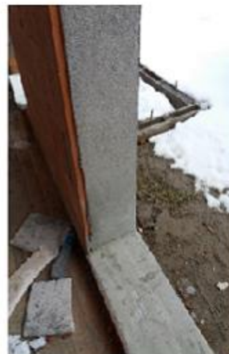
Obrázek č.3 Parapetní zdivo a ostění připravené pro kotvení okenního rámu
